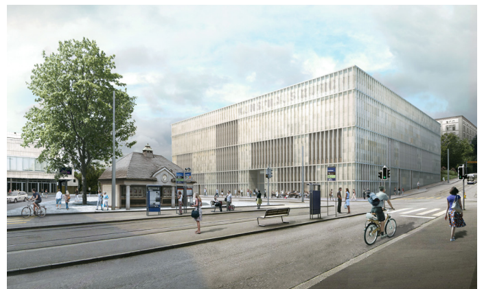
Kunsthaus Zürich (2020), David Chipperfield Architects, London: Sämtliche Ortbetonbauteile inkl. wasserdichter Bauteile aus RC-C-Beton und CEM III/B; CEM III/B, heller Beton auch aufgrund der ästhetischen Qualitäten gewählt.
