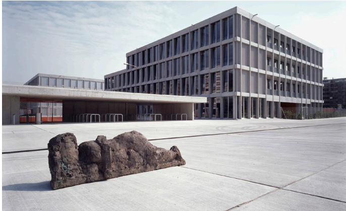
Schulhaus Im Birch (2004), Peter Märkli mit Gody Kühnis, Zürich: Vor Ort gegossene Bauteile wurden ca. hälftig aus aufbereiteten oder recycelten Granulaten hergestellt.
