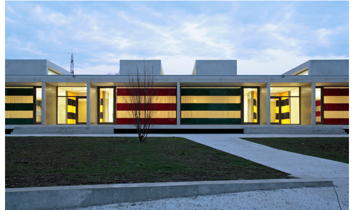
Schulanlage Hirzenbach (2008), Boltshauser Architekten, Zürich: RC-C eingefärbt mit Flüssig-Pigment für Sichtbeton; RC-C für restliche Betonbauteile.
