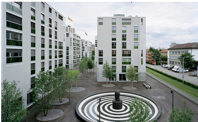
Wohnsiedlung Werdwies (2007), Adrian Streich Architekten, Zürich: Wasserdichtes Untergeschoss und Decken aus RC-C; Tragende Wände aus RC-M aus 100 % mineralischem Mischabbruch.
