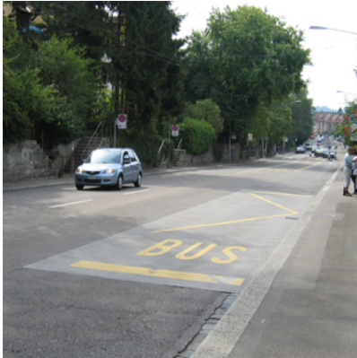
Betonplatte bei Bushaltestelle
