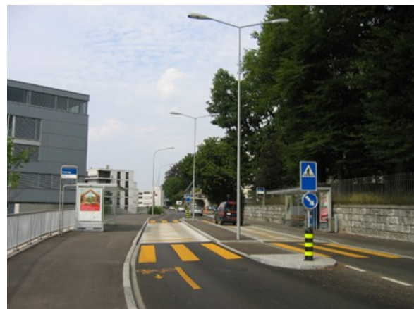
Haltestelle Hürlimannplatz. Haltestelle in Kernfahrbahn mit asphaltierter Mittelinsel, Fahrbahn im Haltebereich aus Beton.
