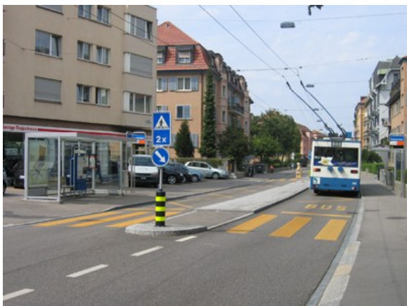
Haltestelle Thujastrasse. Haltestelle mit gepflasterter Mittelinsel, Fahrbahn im Haltebereich aus Asphalt.
