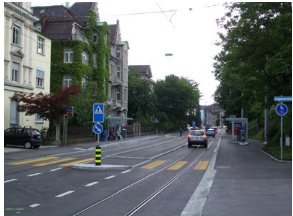
Weinbergstrasse. Haltestelle mit durchgehender Mittelinsel und Querungen für den Fussverkehr.
