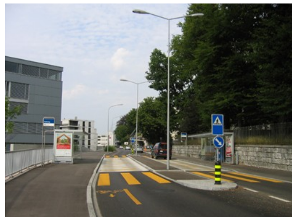
Haltestelle Hürlimannplatz. Haltestelle in Kernfahrbahn mit asphaltierter Mittelinsel, Fahrbahn im Haltebereich aus Beton.
