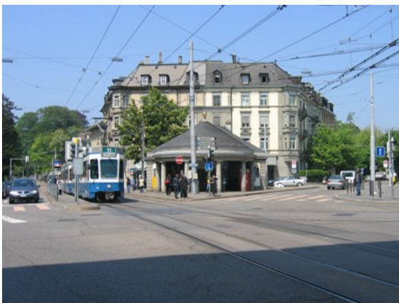
Kreuzplatz. Tram und Bus auf einem Knotenarm.
