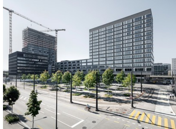
Vulkanplatz Bahnhof Altstetten Nord. Tramwendeschleife in Platz integriert, S-Bahn-Anschluss. (Foto: Beat Bühler)
