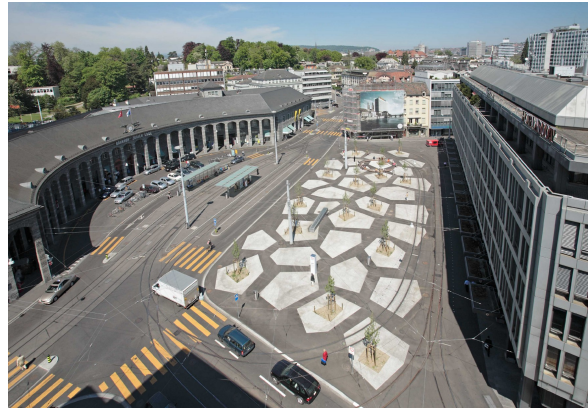
Tessinerplatz Bahnhof Enge. Tramwendeschleife in angrenzenden Platz integriert. (Foto: Beat Bühler)
