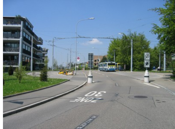
Kienastewies. Wendeschleufe auf durchgehender Strasse.
