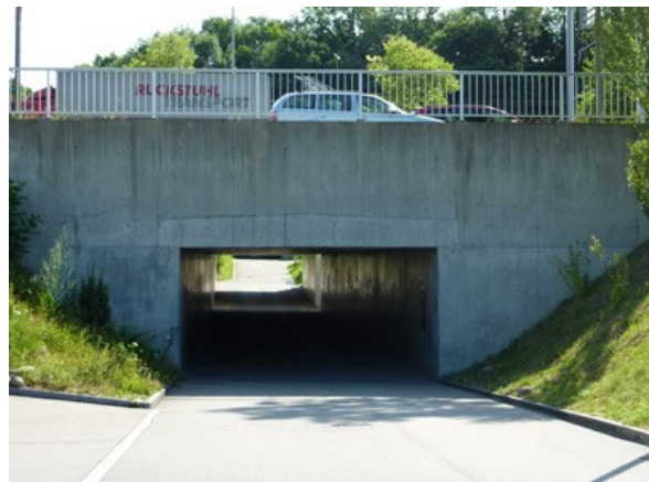
Sportanlage Allmend Brunau / Büttenweg. Personenunterführung unter Allmendstrasse.
