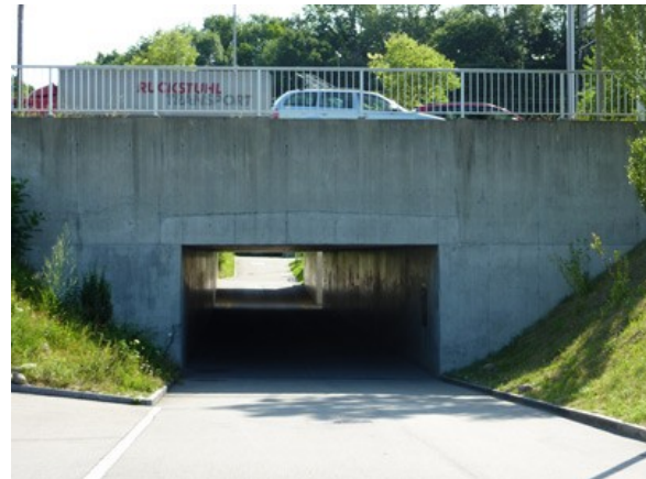
Sportanlage Allmend Brunau / Büttenweg. Personenunterführung unter Allmendstrasse.
