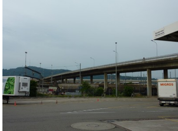
Duttweilerbrücke. Brücke über Gleisfeld und Industrieareal.
