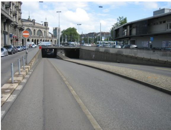
Bahnhofquai. Wichtige Unterführung des Bahnhofplatzes für den motorisierten Individualverkehr und Velofahrende, Ebene -1.
