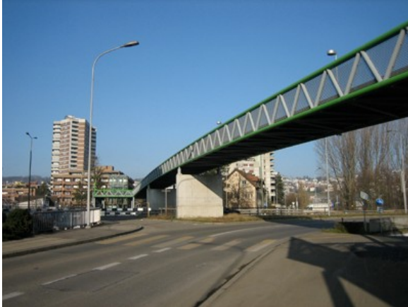
Grünau. Fachwerkbrücke aus Stahl über Autobahn A1.
