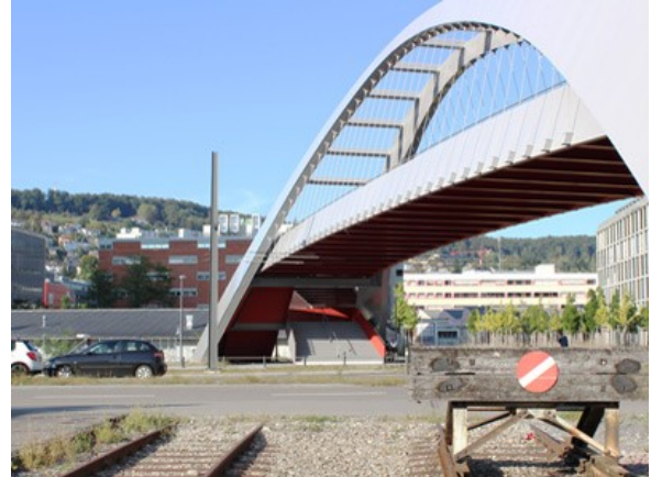
Gleisbogen Zürich-West. Brücke über Hauptverkehrsachse.
