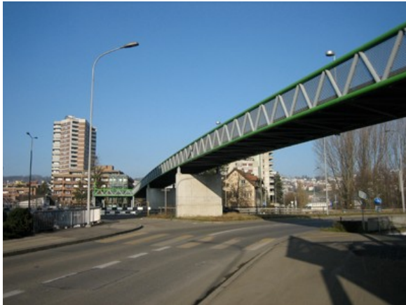
Grünau. Fachwerkbrücke aus Stahl über Autobahn A1.
