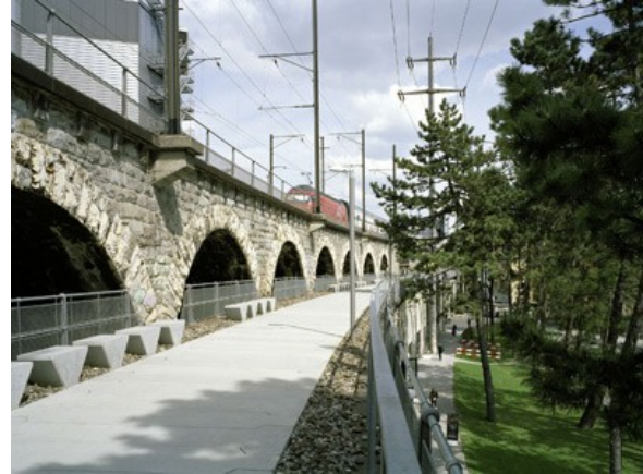
Lettenviadukt. Umgestaltetes Bahnviadukt für Fuss- und Veloverkehr. (Fotografin: Andrea Helbling)
