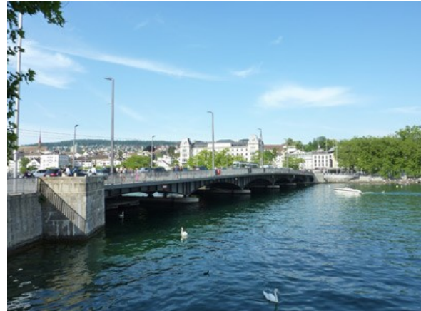
Quaibrücke. Gerade Brücke in bedeutendem Stadtraum.
