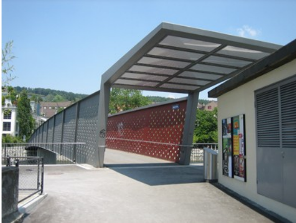
Ampèresteg. Perforation der Seitenwände verbessert Durchsicht, einseitige Traglast ohne Pfeiler, Asphalt.
