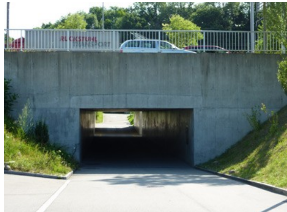
Sportanlage Allmend Brunau / Büttenweg. Personenunterführung unter Allmendstrasse.
