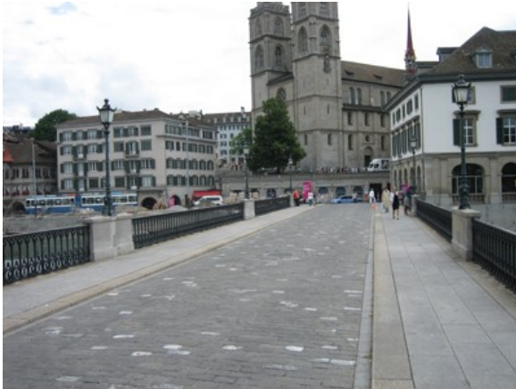
Münsterbrücke. Gerade Brücke für Fuss- und Veloverkehr in bedeutendem Stadtraum.
