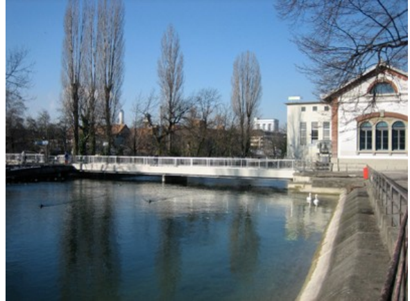
Lettensteg. Stahlverbundsteg, Asphalt.
