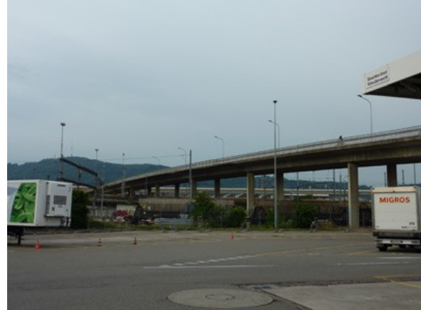
Duttweilerbrücke. Brücke über Gleisfeld und Industrieareal.
