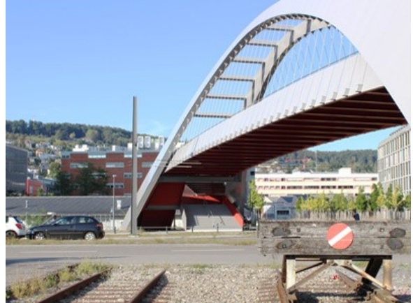
Gleisbogen Zürich-West. Brücke über Hauptverkehrsachse.
