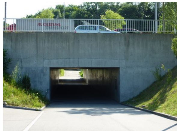
Sportanlage Allmend Brunau / Büttenweg. Personenunterführung unter Allmendstrasse.
