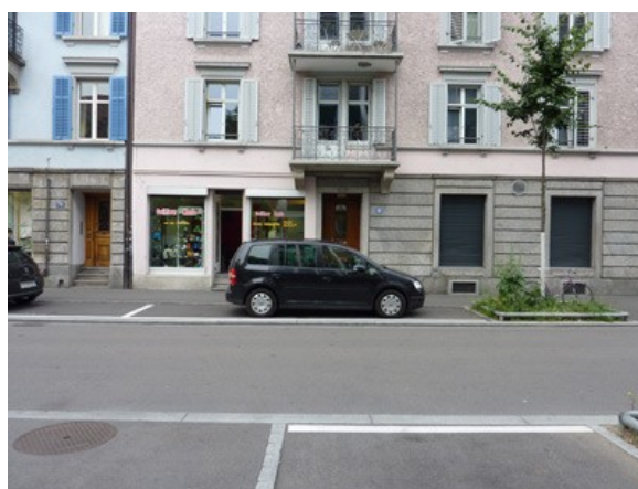
Josefstrasse. Parkfelder mit Bäumen in regelmässigen Abständen.
