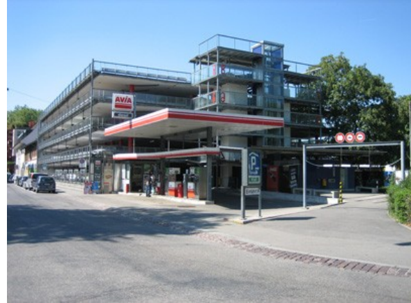
Sihlquai. Freistehendes Gebäude mit separater Zufahrt direkt ab Hauptverkehrsachse.
