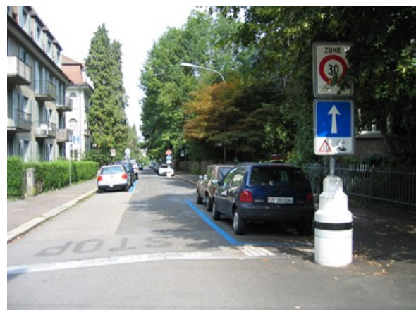
Streulistrasse. Wechselseitige Parkfelder innerhalb Tempo-30-Zone.
