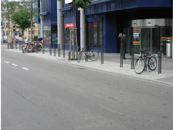
Franklinstrasse. Veloposten in Elementband versetzt (Pflästerung), unmittelbar vor Eingang Neumarkt Oerlikon.
