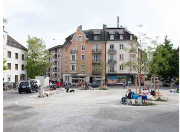
Röschiplatz. Quartierplatz mit chaussierter Fläche und niedrigen Randabschlüssen. (Foto: Dirk Podbielski)
