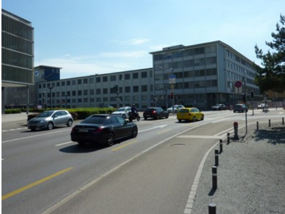
Birchstrasse / Binzmühlestrasse. Lichtsignalgesteuerte Kreuzung, Schutzinsel auf der Mittelachse.
