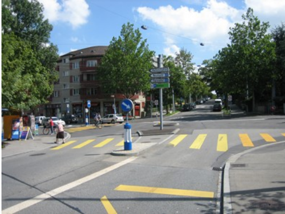
Regensbergstrasse / Hofwiesenstrasse. Mit Tram, Bus und Schutzinseln.
