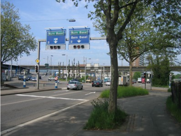
Pfingstweidstrasse / Duttweilerstrasse. Lichtsignalgesteuerte Kreuzung auf Ausfallachse.
