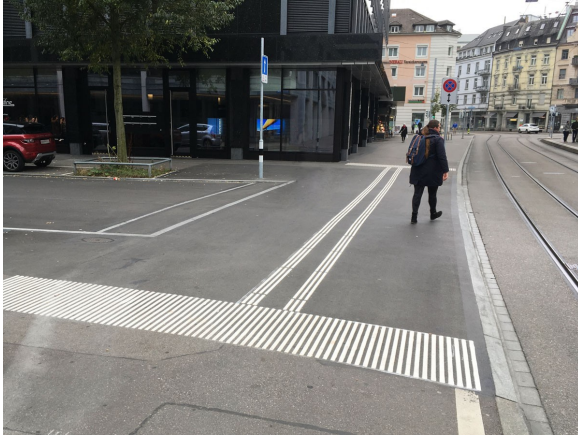
Beethovenstrasse / Bleicherweg. Trottoirüberfahrt.
