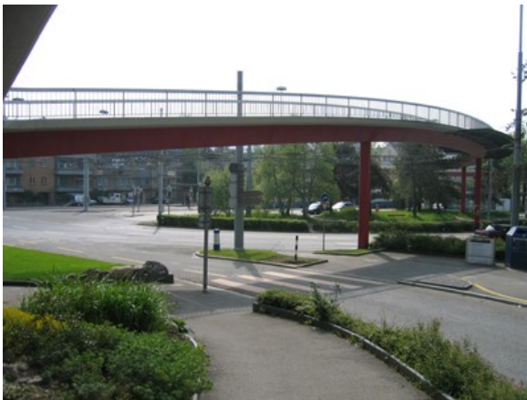
Bucheggplatz. Knoten mit drei Ebenen – Passerelle, Fahrbahn, Unterführung – und parkartigen Bereichen.
