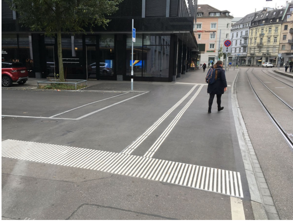
Beethovenstrasse / Bleicherweg. Trottoirüberfahrt.
