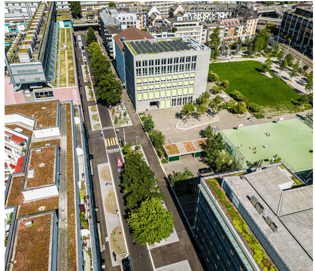
Neuaufteilung des Strassenraums in der Heinrichstrasse
