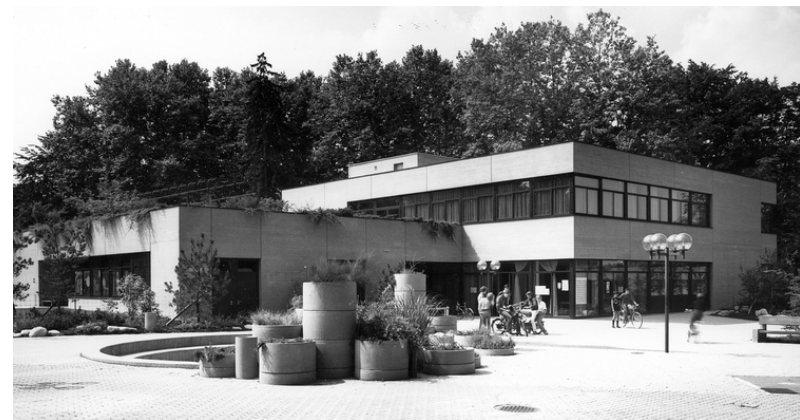
Das Gemeinschaftszentrum Riesbach, erbaut 1977 (Bild: BAZ_130036, Eva Schnyder)
