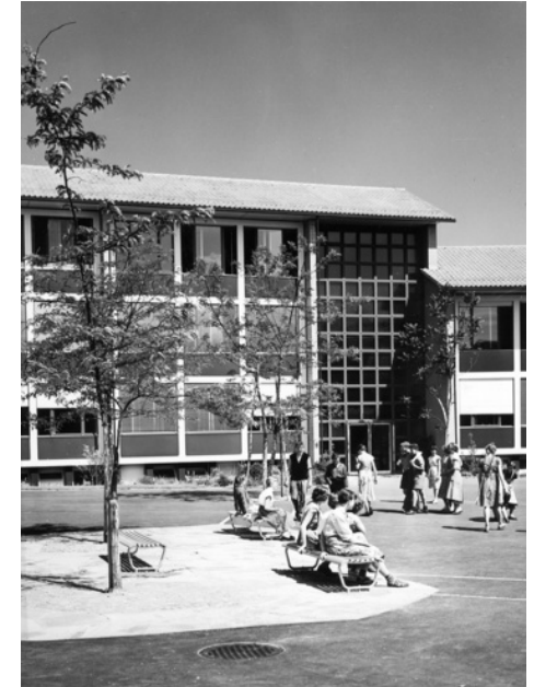
Die weitläufige Schulanlage Herzogenmühle, Baujahr 1955 (Bild: BAZ_133246, Werner Homberger)
