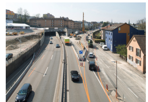
Grossprojekt: Dieser Autobahneinschnitt wird überdacht (Bild: HAL_010779, Juliet Haller)
