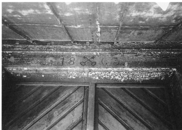
Haldeliweg 10. Werkstättenportal: Detail des Türsturzes mit eingemeisseltem Erbauungsjahr 1863 und zwei gekreuzten Schlüsseln als Emblem. (Foto BAZ, 1999)
