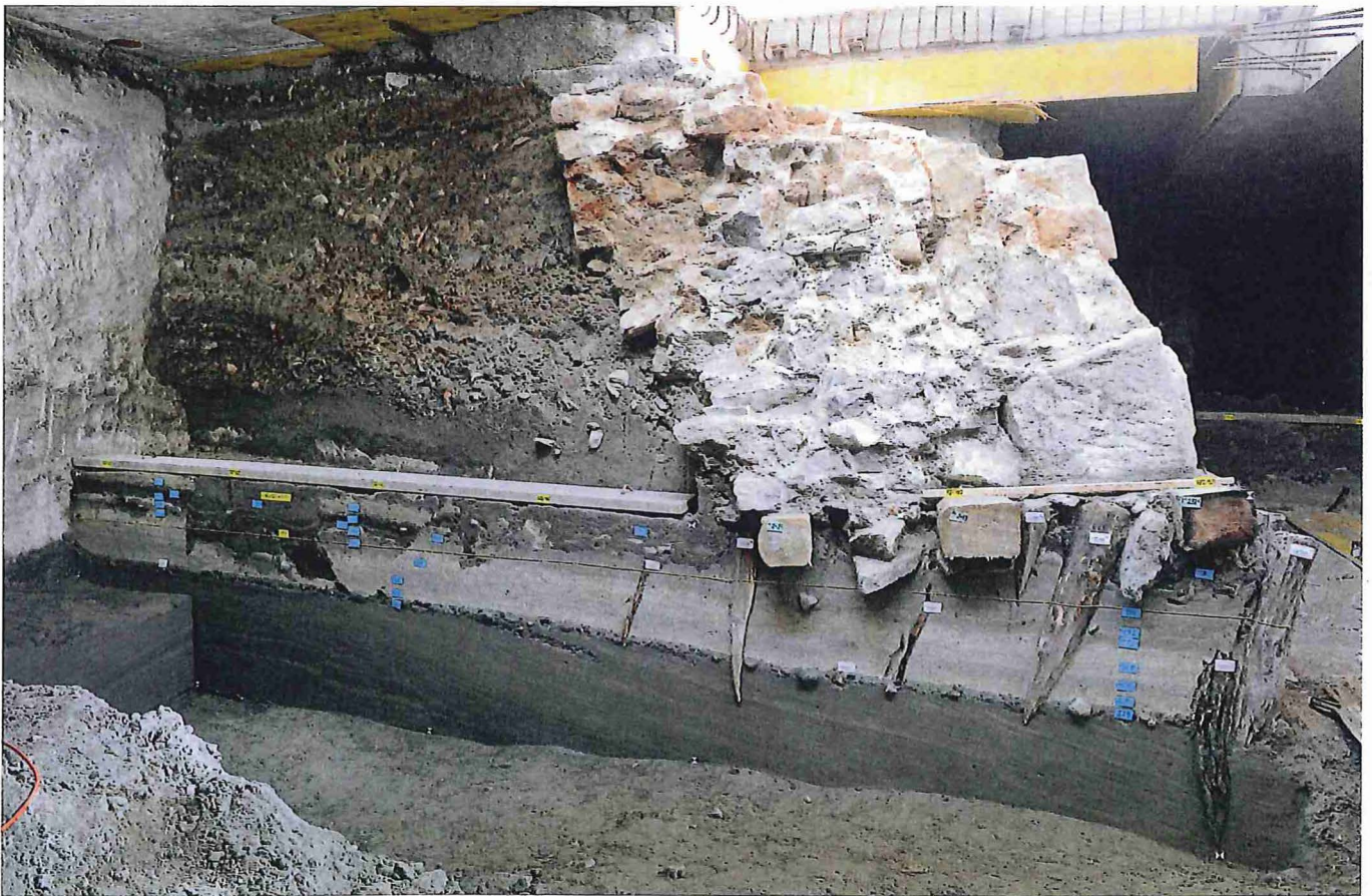
Abbildung 10–11: Ausgrabung Parkhaus Opéra unter dem Sechseläutenplatz, 2009. Rest der Stadelhoferbastion mit sichtbarem Quadermauerwerk, kleinstenigem Mauerwerk, Holzfundationen und Erdaufschüttungen über den Seesedimenten, Ansicht und Schnitt.
