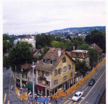
Kreuzplatz 11/Klobachstrasse 1. Über Jahrhunderte der eigentliche Kopfbau, welcher den Kreuzplatz dominierte. (Foto BAZ, 2002)
