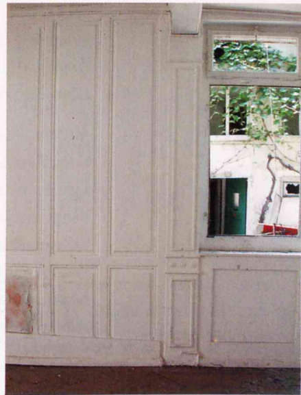
Klosbachstrasse 13. Spätklassizistisches Täfer, eingebaut 1890. (Foto Stadtarchäologie, 2002)
