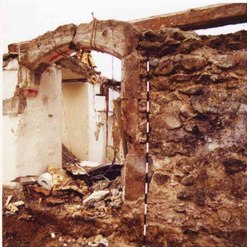
Kreuzplatz 11/Klosbachstrasse 1. Die vom Verputz befreite Mauer des Speichergebäudes. Der Eingang führt in eine Raumecke. Das ermöglichte wahrscheinlich eine bessere Flächenausnutzung im Innern. (Foto Stadtarchäologie, 2002)
