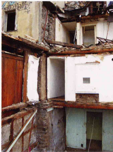
Kreuzplatz 10/11/Klosbachstrasse 1. Bauforschung während dem Abbruch: Bauten des 17. und 18. Jahrhunderts stehen auf der und stossen an die Nordecke eines älteren Steingebäudes (Seite 48). (Foto Stadtarchäologie, 2002)
