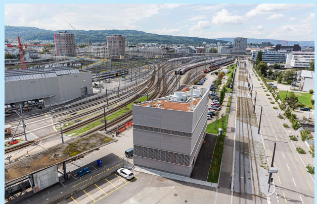
Der Energieverbund von ewz an der Aargauerstrasse liefert Wärme und Kälte für bestehende Liegenschaften und neue Überbauungen in Zürich Altstetten.
