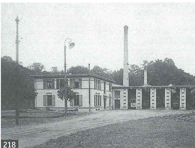
Tramdepot Burgwies aus: Baukultur in Zürich, Verlag NZZ, 2003
