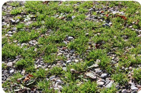
Schotterrasen sind begrünte, versickerungsfähige Beläge aus einer Mischung von Kies und Kulturerde. Die extensive, lockere Vegetationsdecke mit niedrigwachsenden Gräsern und Kräutern weist eine grosse Trockenheitstoleranz auf. Der Belag eignet sich für gelegentliches Befahren mit motorisierten Fahrzeugen und fügt sich gestalterisch gut in Rasen- und Wiesentypen ein.
