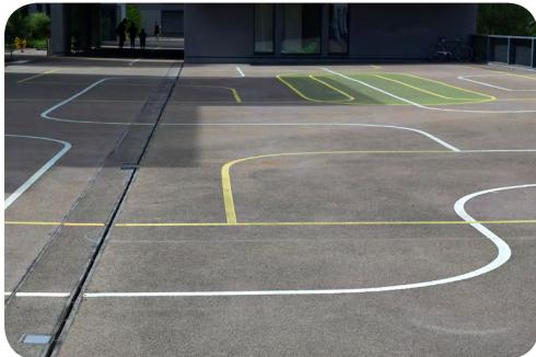
Asphalt oder Ortbeton sind grossflächige Beläge ohne Fugen. Asphalte sind Mischungen aus mineralischen Bestandteilen und bitumösen Bindemitteln, während Ortbeton mit Zement gebunden wird. Beläge ohne Fugen eignen sich für Wege, Plätze, Einfahrten, Gartenwege und andere stark frequentierte Orte. Je nach Aufbau und Dicke der Tragschicht ist der Belag befahrbar oder nicht befahrbar.
