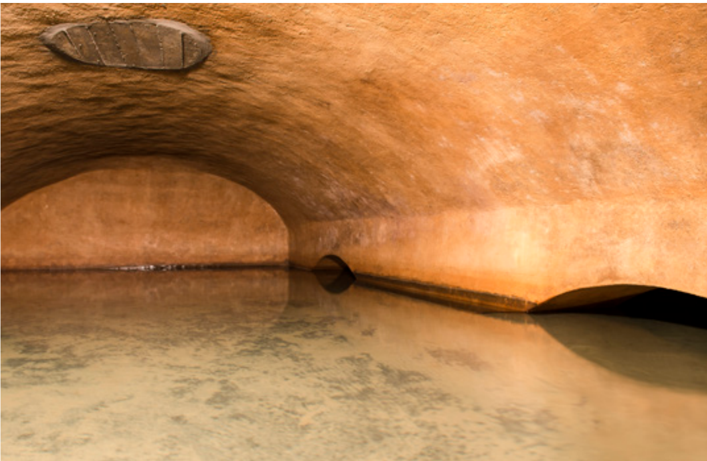
Quellwasserfilter Dolder
